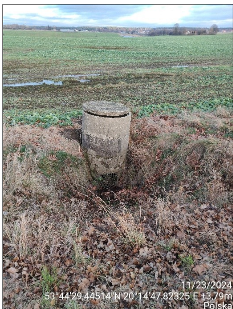
zdj. 5 Studzienka melioracyjna
