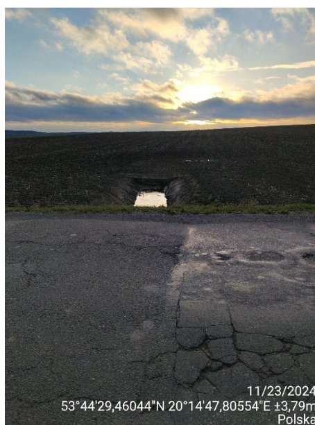
zdj. 8 dół chłonny po drugiej stronie drogi DP1370N
