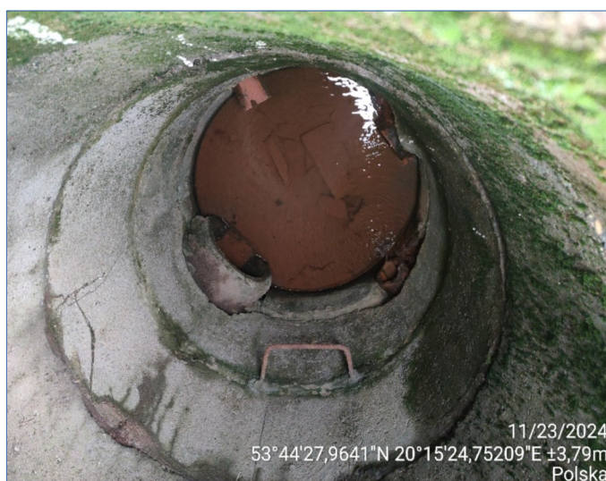
zdj. 18 i 19 dno studzienki z włączeniami sączków drenażowych oraz układu zbiorczego odprowadzającego
