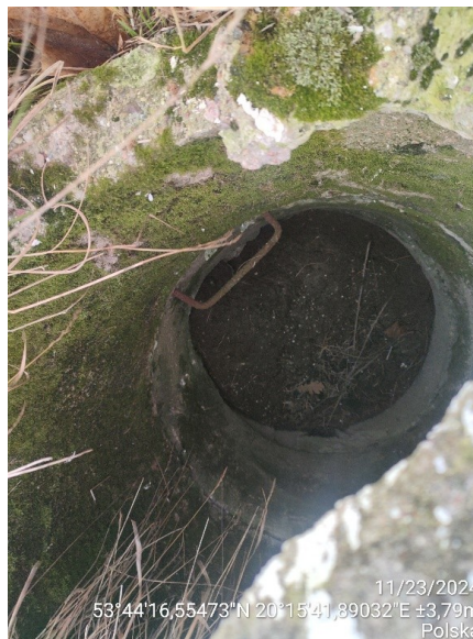
zdj. 21 dno studzienki zasypane urobkiem
