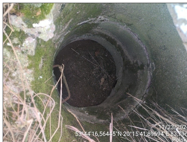
zdj. 23 dno studzienki zasypane urobkiem
