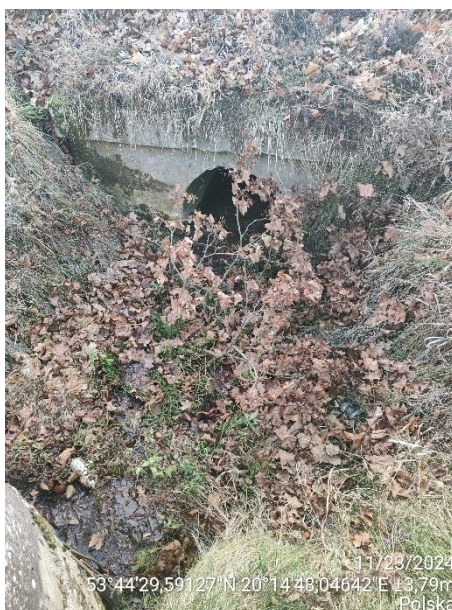
zdj. 7 przepust drogowy pod drogą DP1370N
