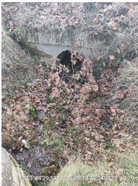
zdj. 7 przepust drogowy pod drogą DP1370N
