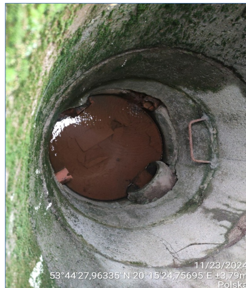
zdj. 18 i 19 dno studzienki z włączeniami sączków drenażowych oraz układu zbiorczego odprowadzającego
