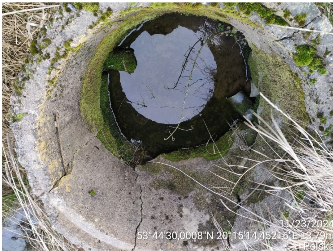
zdj. 15 dno studzienki z istniejącymi wlotami i wylotami sączków drenażowych
